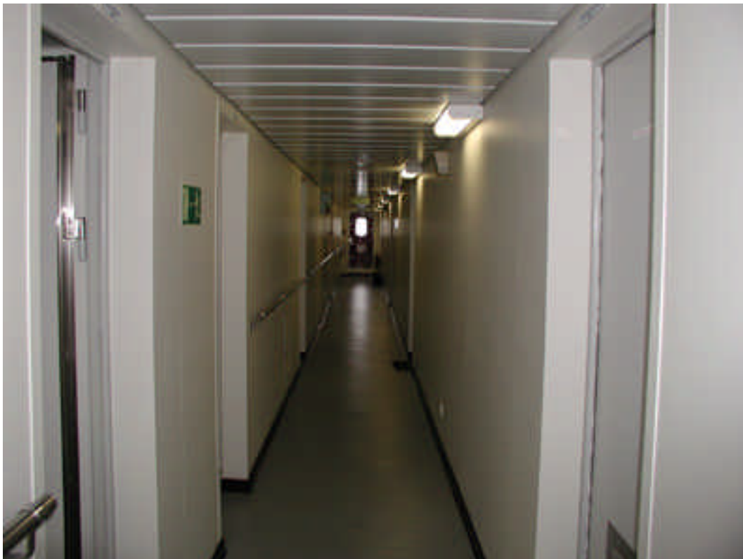
Abb.1: Betriebsgänge meist mit einheitlicher Farbgebung für Türen auch in den Treppenhäusern auf allen Decks.
